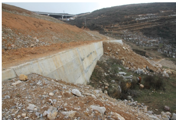
图 3 弃土场拦渣墙现状
