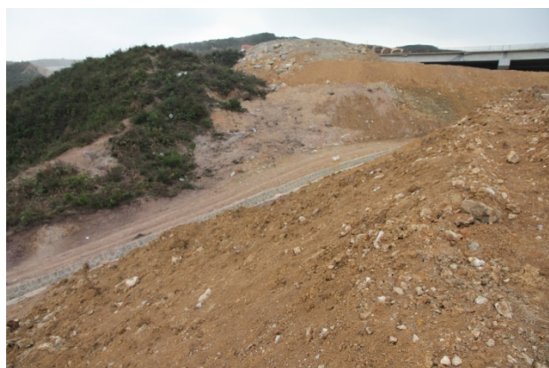
图 4 弃土场右侧排水沟
