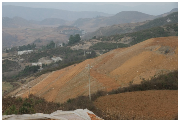
图 5 弃土场边坡现状
