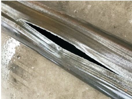
注: TG02 波纹管发生爆裂破坏时的膨胀压力为 14 MPa, 裂隙长度 20 cm, 最大宽度 2 cm
