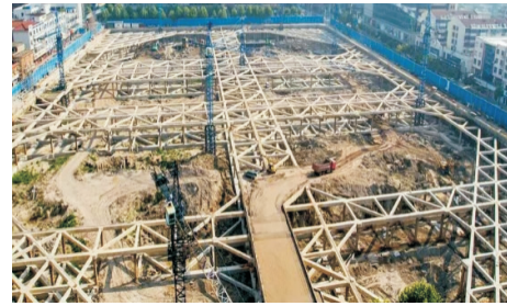
图7 基坑施工现场
