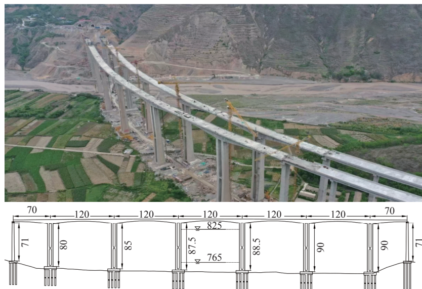
图 3 小江特大桥实体及结构图 (单位: m)
