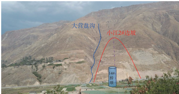
图4 桥基边坡地貌
