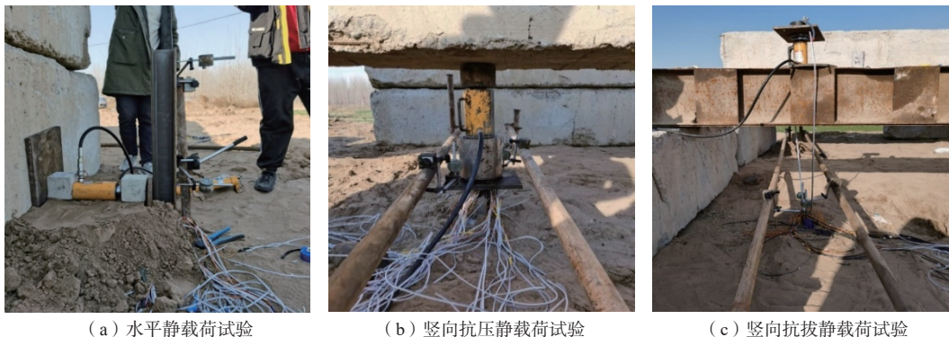
图 5 型钢桩现场静载荷试验图
