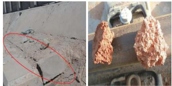
图1 隆起病害(左)及膨胀泥岩图(右)
