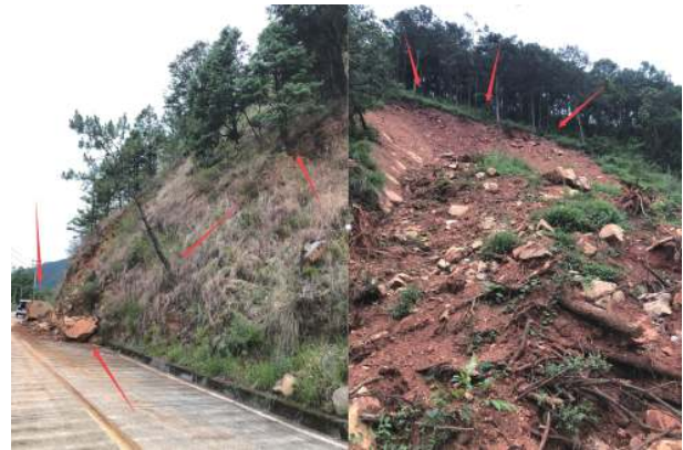
图 3 2#监测点附近山脊部位的落石以及斜坡变形
