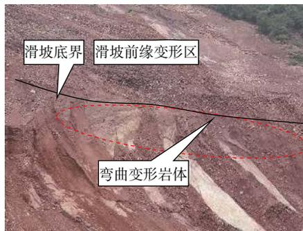
图 8 滑坡前缘弧状弯曲岩体
