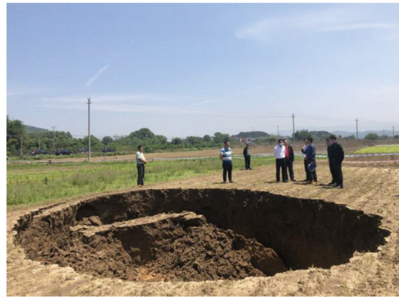
(b) T3塌陷坑
