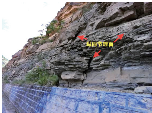
(a) 破裂面粗糙宽大的纵向节理
