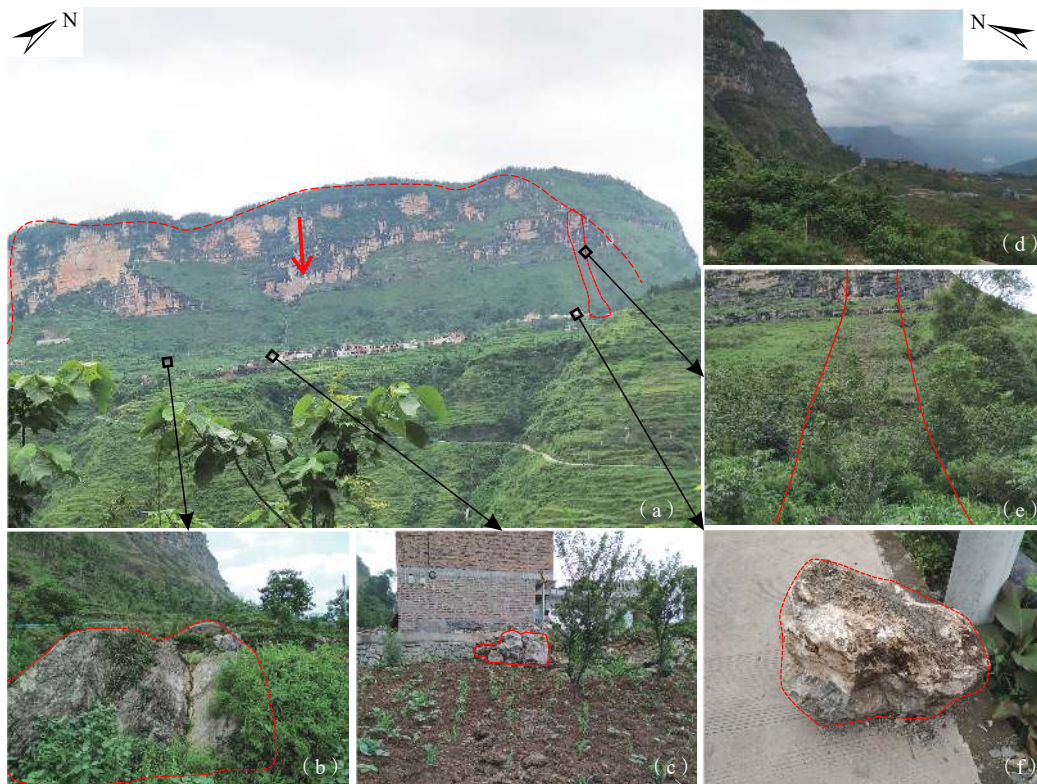
图 2 独家寨崩塌变形破坏特征
