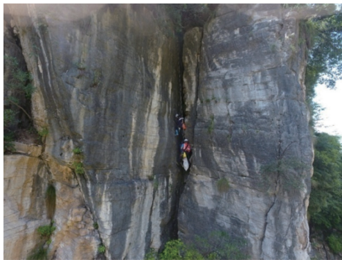
图3 单绳升降技术(SRT)调查岩壁卸荷裂隙
