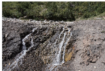
(b) 碎裂-散体状灰岩 (镜向285°)
