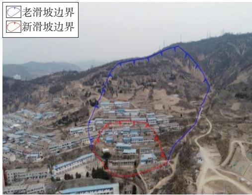
图 1 二庄科滑坡全貌
