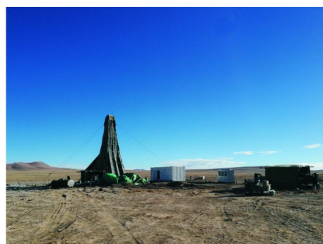
图5 调查井施工现场
