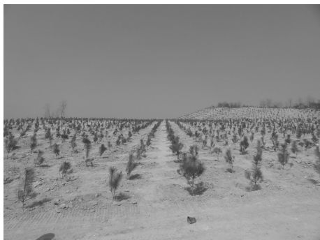
图 4 4 号塌陷带陡崖治理后效果
