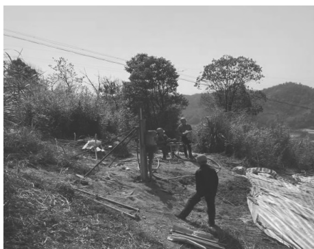
图 2 钢管桩钻孔
