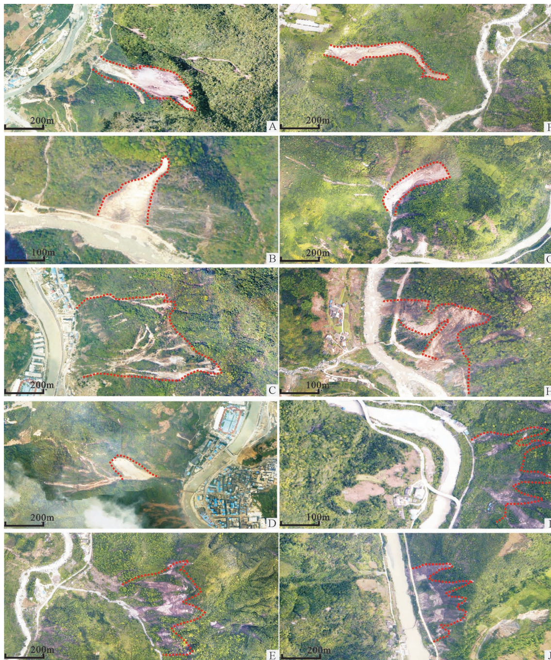
A~J.宝兴地区省道S210两侧集中发育的崩塌滑坡(影像来源于四川测绘地理信息局)(图片具体位置见图4)
