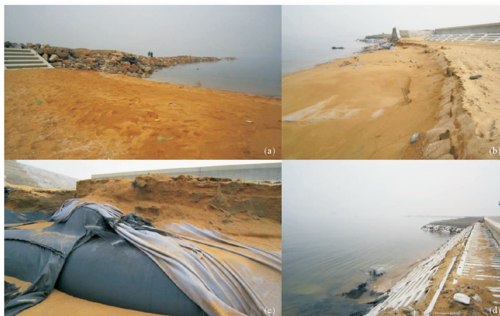
a 西丁坝根部沙滩; b 沙滩中部发育侵蚀陡坎; c 沙滩东中部侵蚀陡坎逼近防潮坝胸墙,充填袋和格栅被移至岸边; d 沙滩东部几近完全消失
