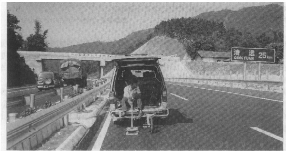
图1 透地雷达检测现场
