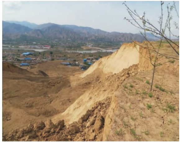
(b) 20150429罗家坡段滑坡全貌
