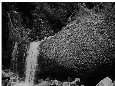
图1 日本被动柔性防护网工程
