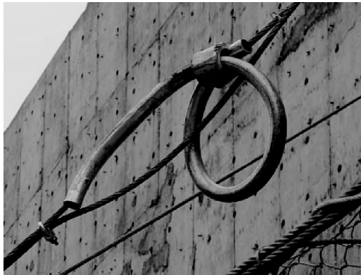
图 15 T-2 冲击试验后上锚减压环 5 变形图
