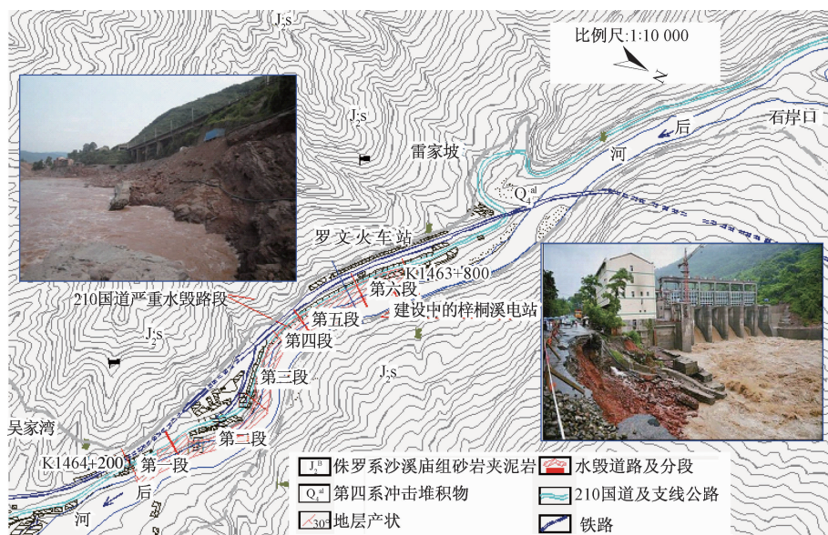
图2 后河梓潼溪电站下游河段河流右岸岸坡塌岸分布及分段
