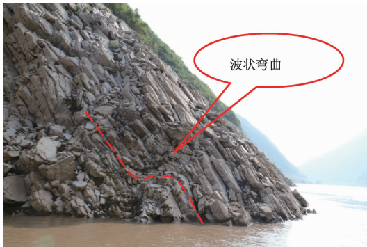
图 3 青岩子 3#斜坡冲沟内的岩层弯曲现象
