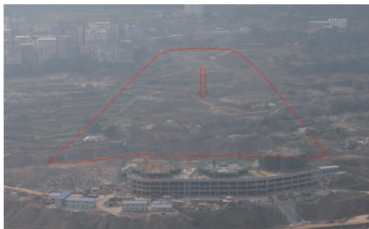
图3 某在建工程深厚层土质滑坡全景照片
