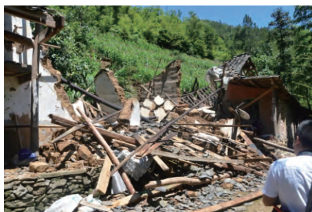
图2 红层典型浅表层土质滑坡照片(前缘房屋垮塌)
