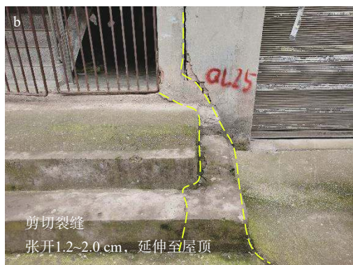
(b) 台阶剪切裂缝
