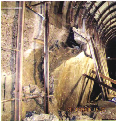
图 5 左(北)边墙挤裂、折断、倾倒
