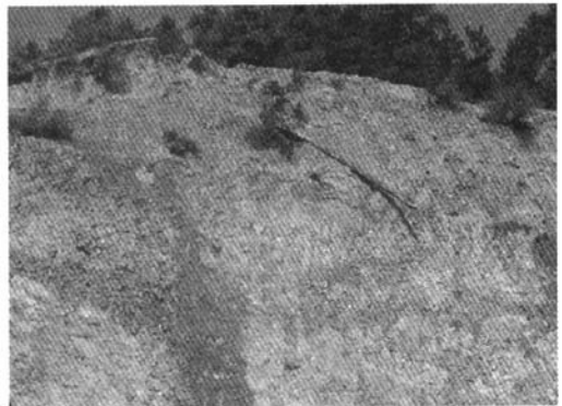
图 2 开采边坡高陡边坡及崩塌隐患
