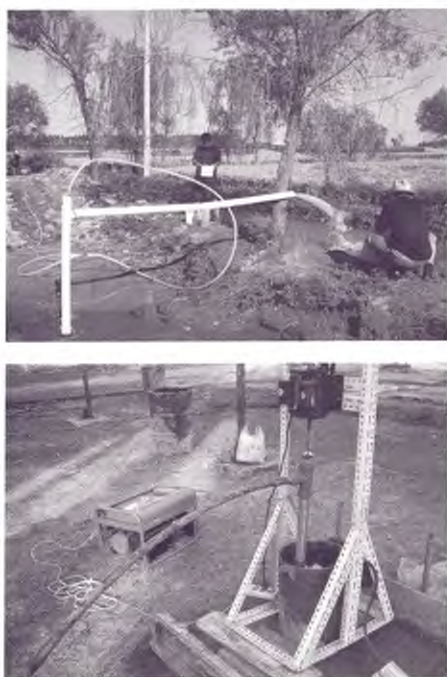
图3 监测井洗井现场
