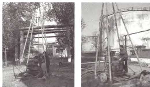
图 1 某石油化工厂钻进施工现场
