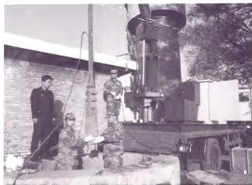
图7 野战洗井抽水装置洗井图片
