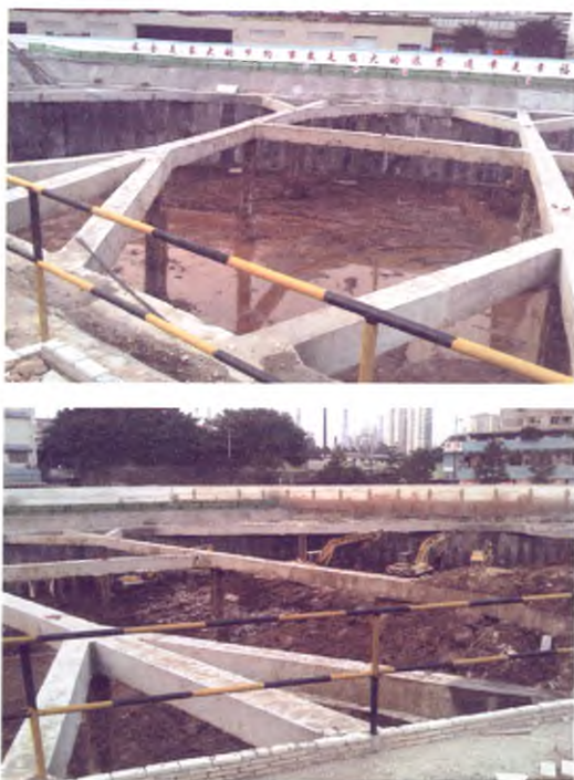
图6 基坑完成后实景图
